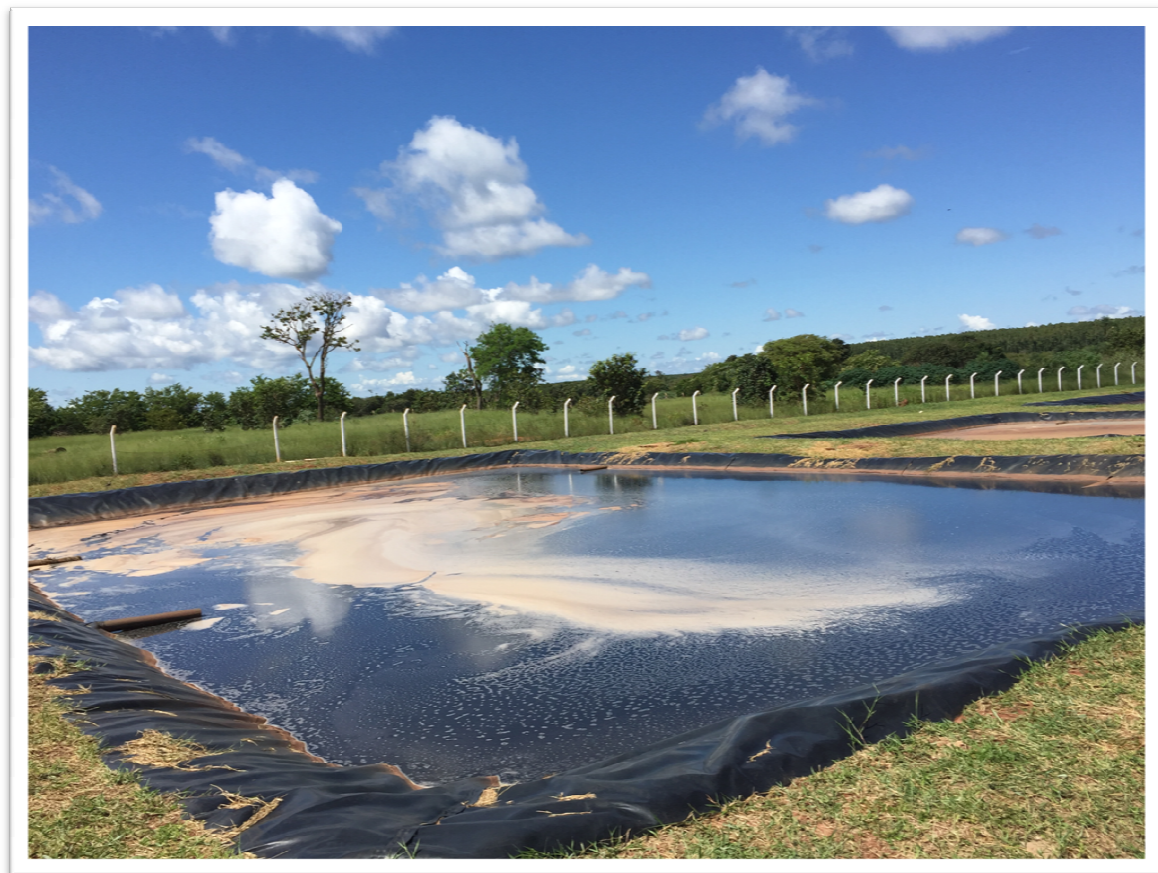
Figura 3 - Lagoa Anaeróbica | Antes do Tratamento
