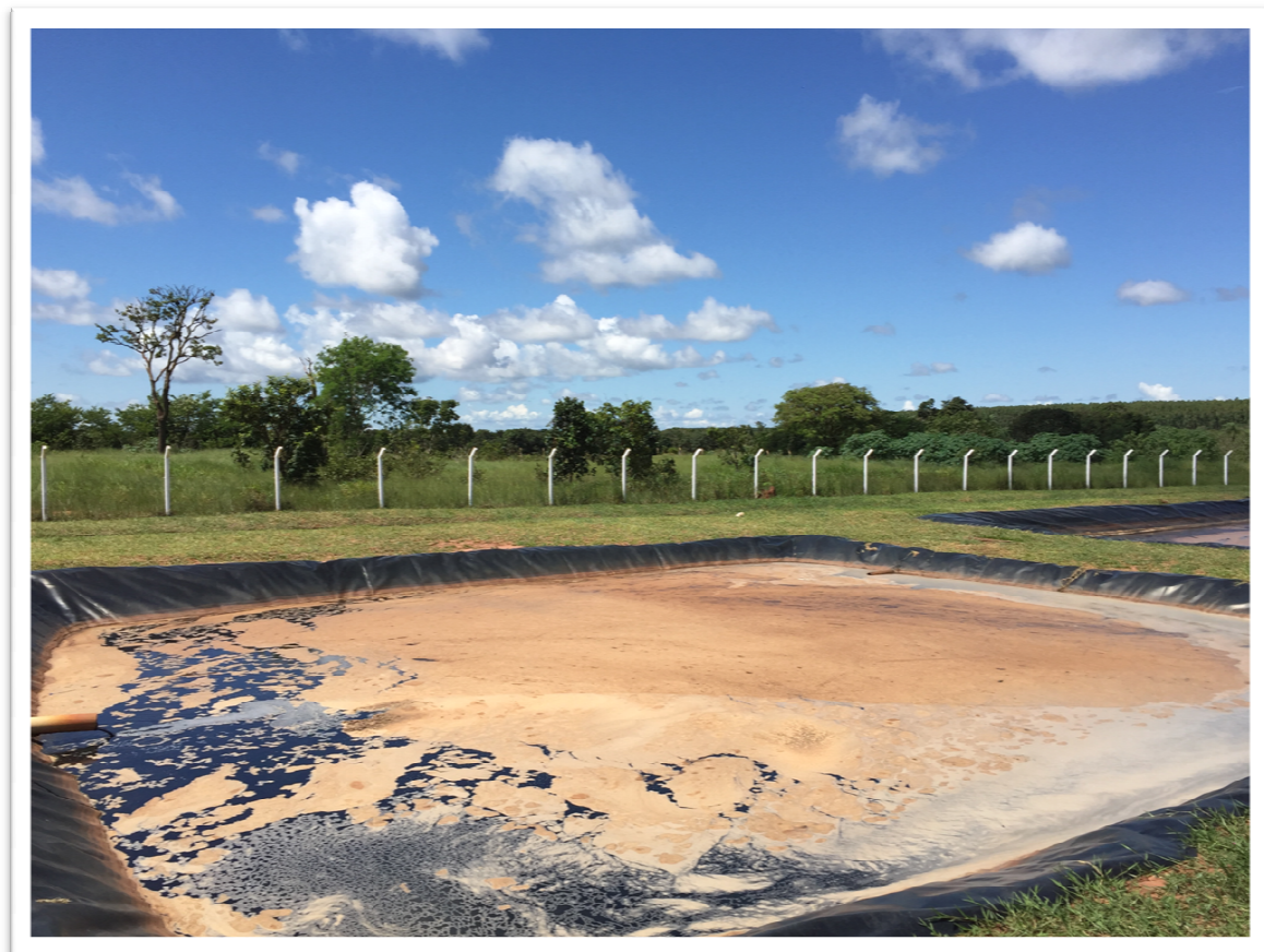
Figura 5 - Lagoa Anaeróbica II Antes do Tratamento
